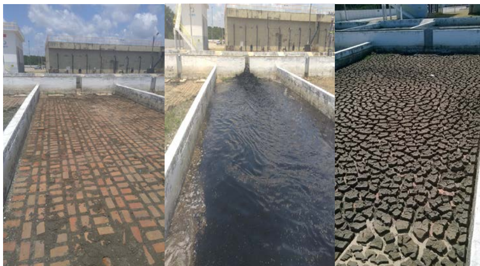
Figura 2 – (a) Leito de secagem pronto para receber o lodo, (b) sendo descarregado e (c) com o lodo seco após 15 dias.
